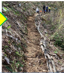
路肩が斜めの道を水平に均し、倒木を路肩の土止めに活用。約50m
