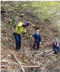
路肩が斜めの道を水平に均し、倒木を路肩の土止めに活用。約50m
