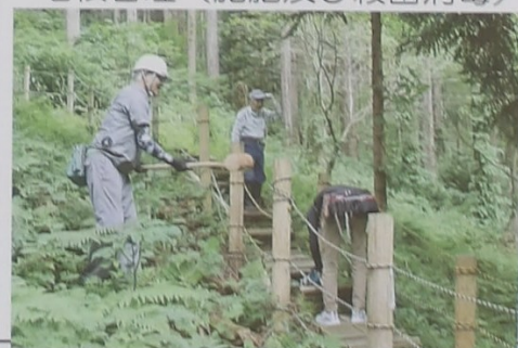
板歩道の補修作業
