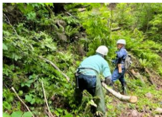
薬師の森遊歩道整備
