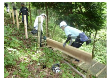
板歩道の補修作業
