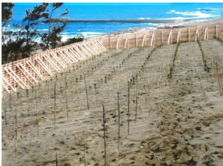
（防風柵の設置）
